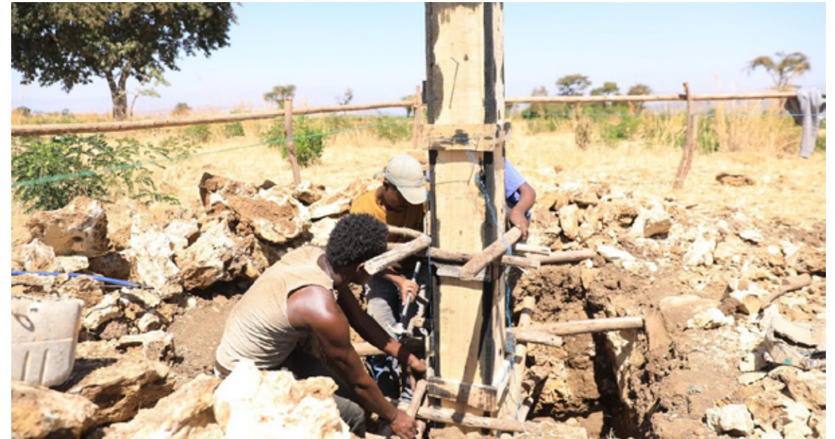
Statt aus Holz, Lehm und Wellblech entsteht die neue Debeka Higher Primary School aus geeigneteren Baumaterialien, wie Beton und Stahl.
