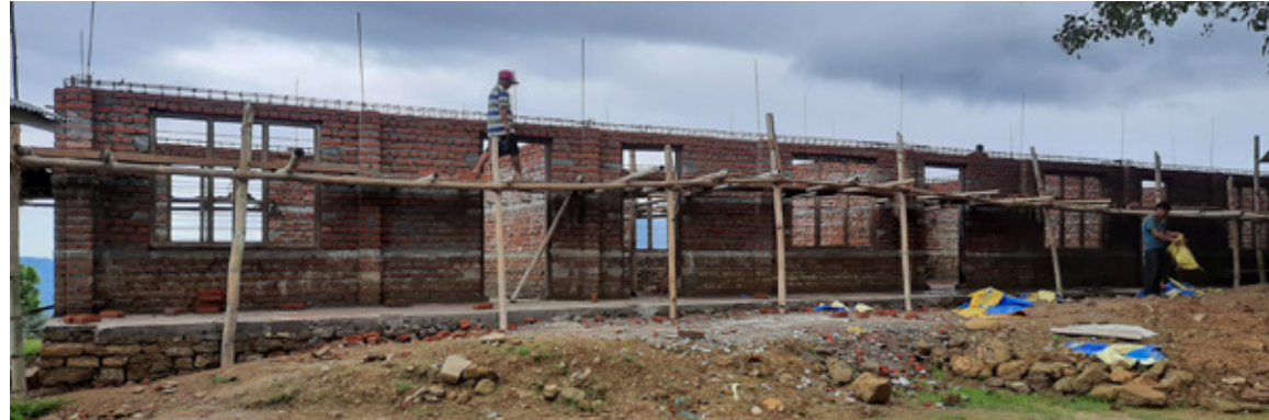
Hier entsteht in Karangekot ein kinderfreundliches Schulgebäude mit vier Klassenräumen und Toiletten.
