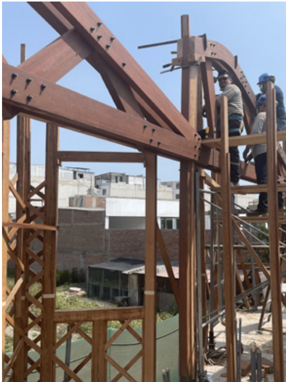
Die Bauarbeiten für das neue Therapiezentrum gehen voran.
