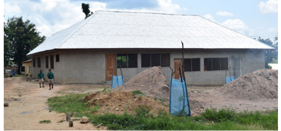
Nach einem heftigen Tropensturm in Ghana konnte ein Gebäude dieses zerstörten Kindergartens wieder aufgebaut werden.
