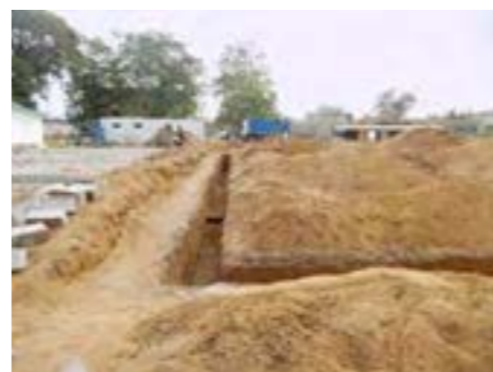
Start der Bauarbeiten für eines der zwei neuen augenmedizinischen Zentren.
