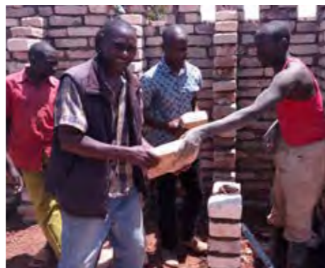
Neubau einer Schule in der Region Mbeya.
