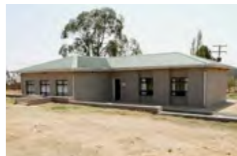
Das neue Gebäude bietet jetzt Platz für bis zu 60 Kinder.
