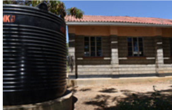
Mit der Spende wurden insgesamt zwei Wassertanks in einem Zentrum für ehemalige Straßenkinder errichtet.
