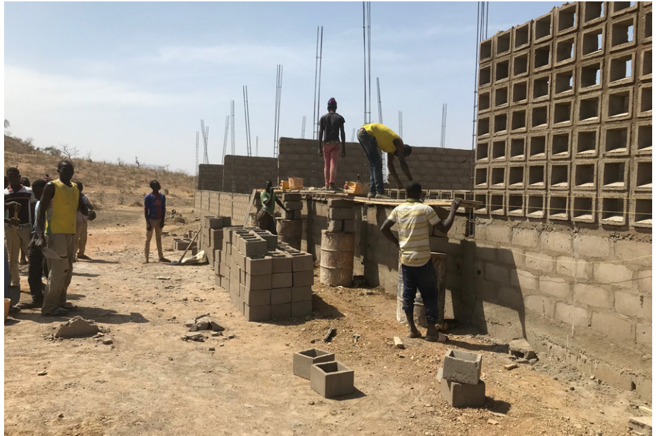
Alle packen mit an: Hier entsteht eine von zwei neuen Grundschulen.
