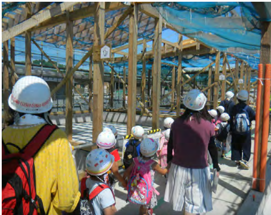
Der Neubau der Kinderkrippe in der 2011 vom Erdbeben stark getroffenen Stadt Ishinomaki schreitet gut voran.
