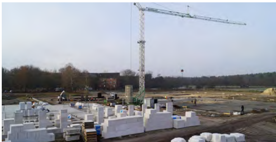
Der Bau der „Schule ohne Grenzen“ in Berlin konnte endlich starten.
