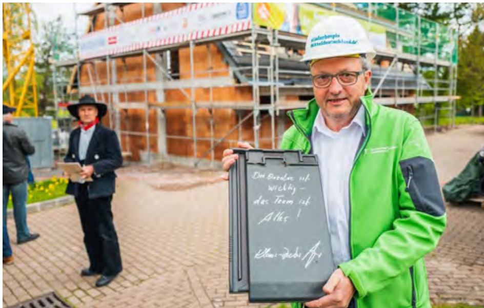
Der Geschäftsführer des Kinderhospizes Mitteldeutschland Klaus-Dieter Heber beim Richtfest für das neue Gebäude des Kinderhospizes in Tambach-Dietharz.
