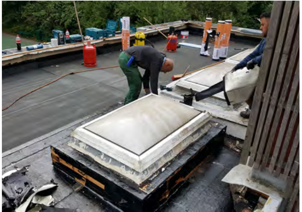
Die Reparaturarbeiten an dem Dach der „ARCHE“ in Hamburg waren dringend nötig.
